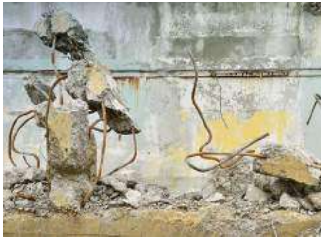
Béton de démolition
