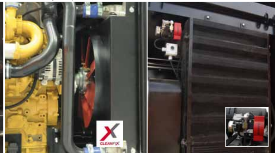
Cleanfix reverse du ventilateur du système de refroidissement moteur et/ou du circuit hydraulique
